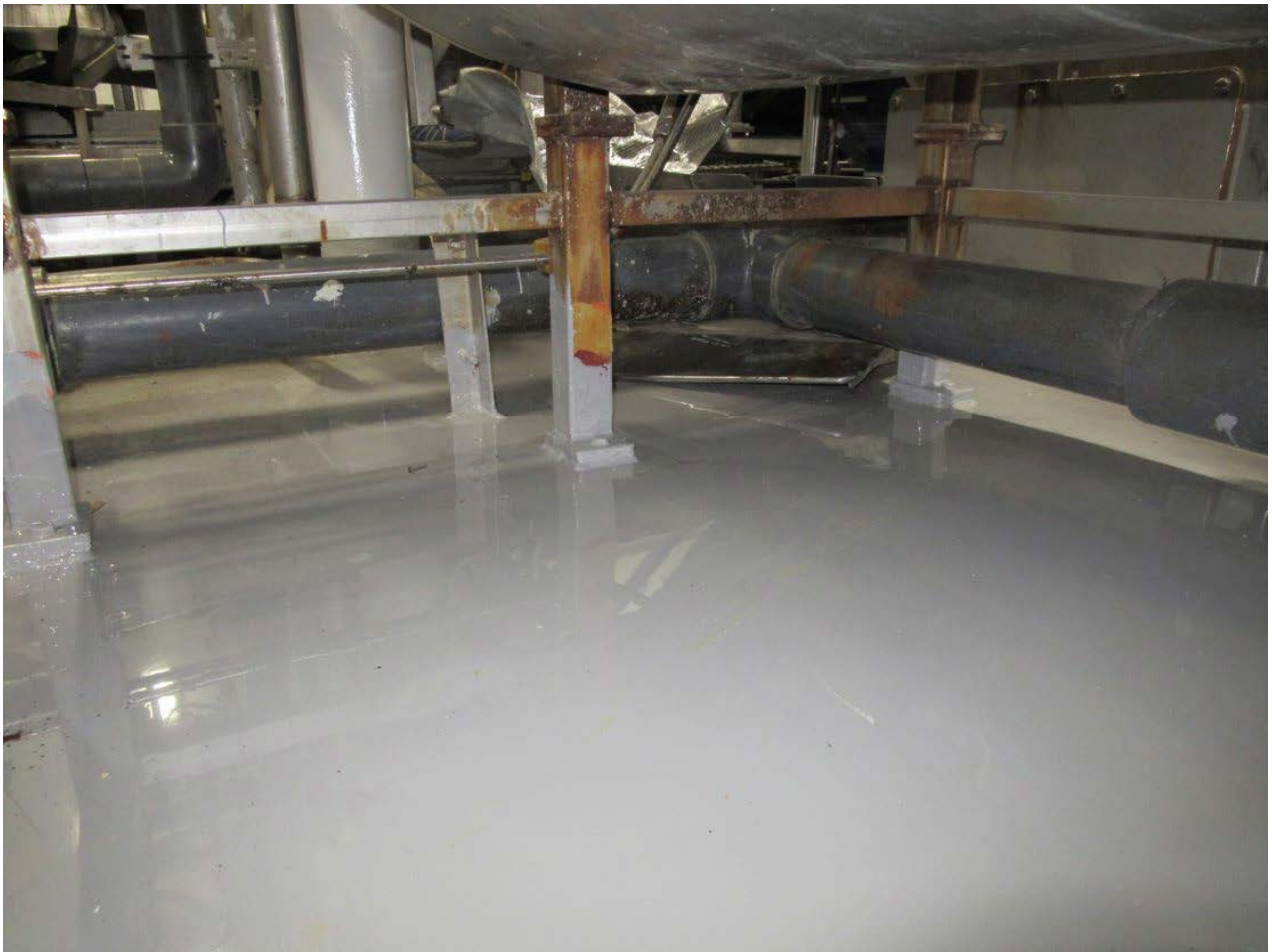
Figur 4-12 Dekket er reparert med nytt deksbelegg.
